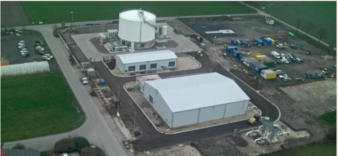
Bild 1: Übersicht der Konvertierungsanlage in Rehden [5]
